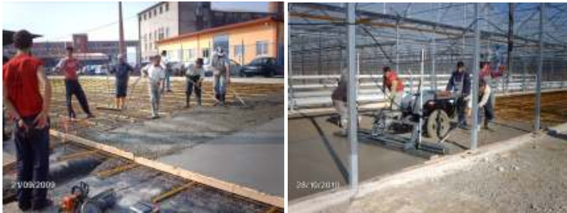
Slika 6. Ugradnja betona pervibratorom i vibroletvom
