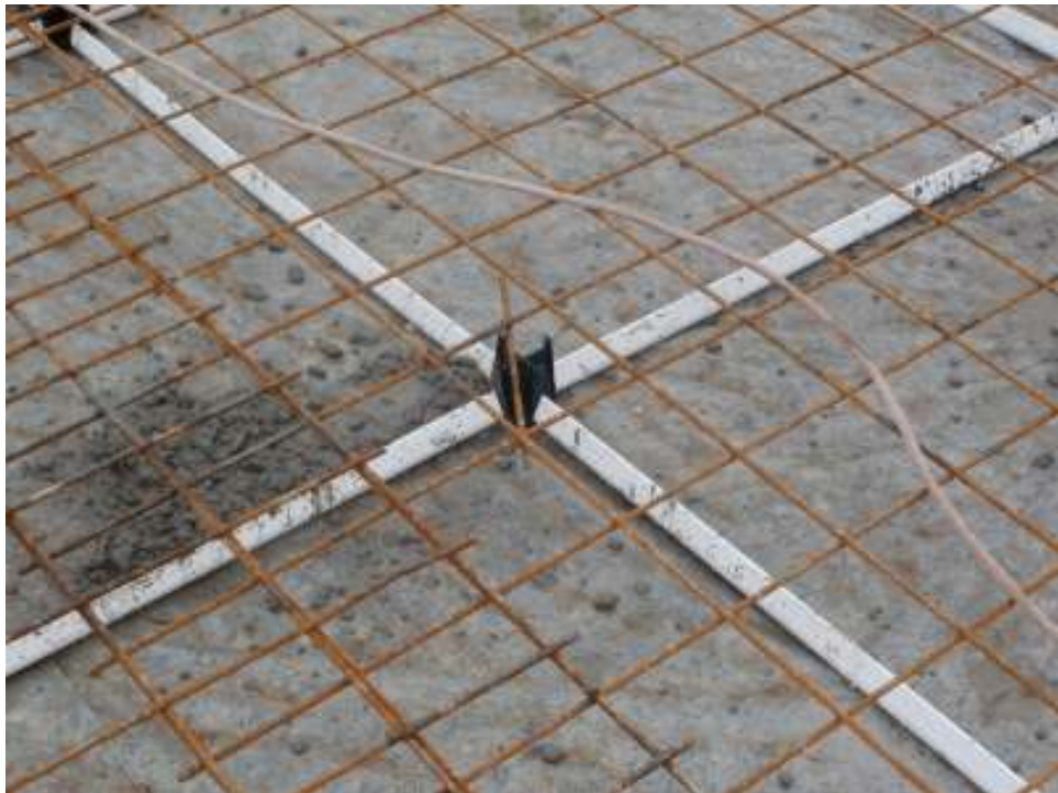
Slika 3. Podizanje armaturnih mreža na visinu
