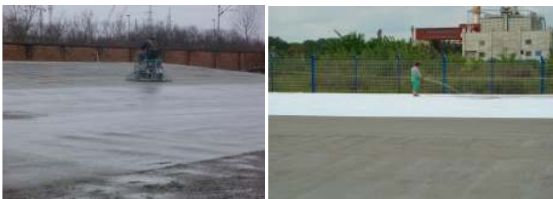
Slika 8. Obrada površine ploče helikopterom te njega svježeg betona
