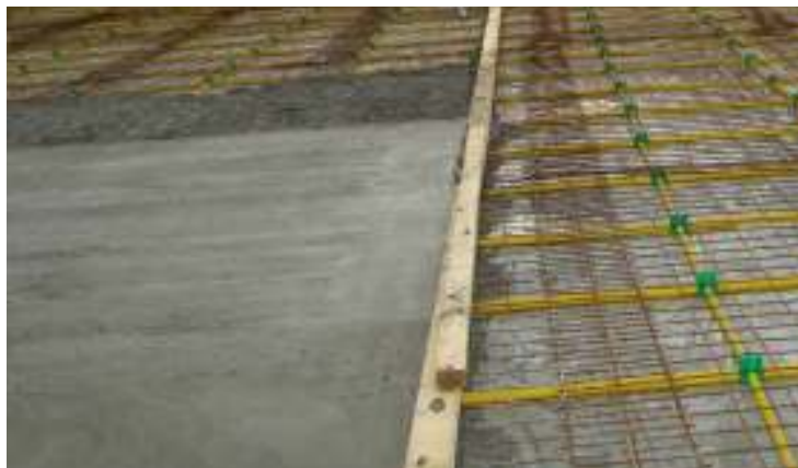
Slika 7. Dnevni prekid betoniranja
