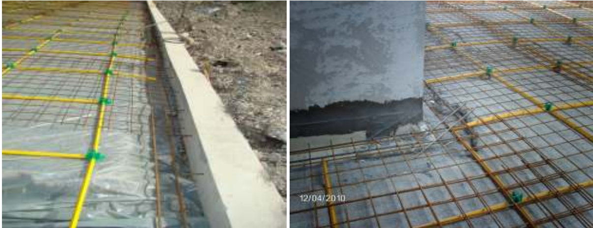
Slika 4. Dodatna armatura – rubne grede i uglovi
