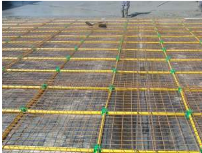
Slika 2. Postavljanje armaturnih mreža na mrežu INB 06
