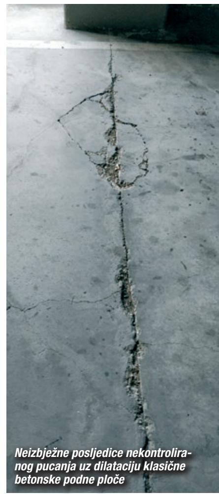
Neizbjježne posljedice nekontroliranog pucanja uz dilataciju klasične betonske podne ploče
